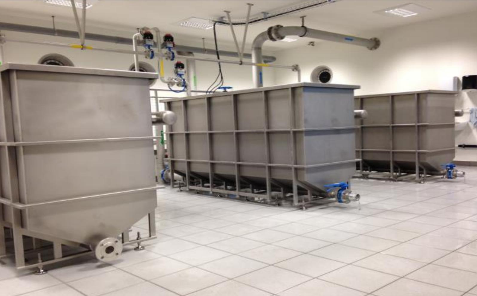
Die Dimensionierung, Lieferung und Inbetriebnahme einer Ultrafiltrationsanlage für den Neubau des Reservoirs «La Tuilerie» erfolgt mit dem Ziel, die Trinkwasserversorgung der Gemeinde Corgémont im Berner Jura sicherzustellen.
