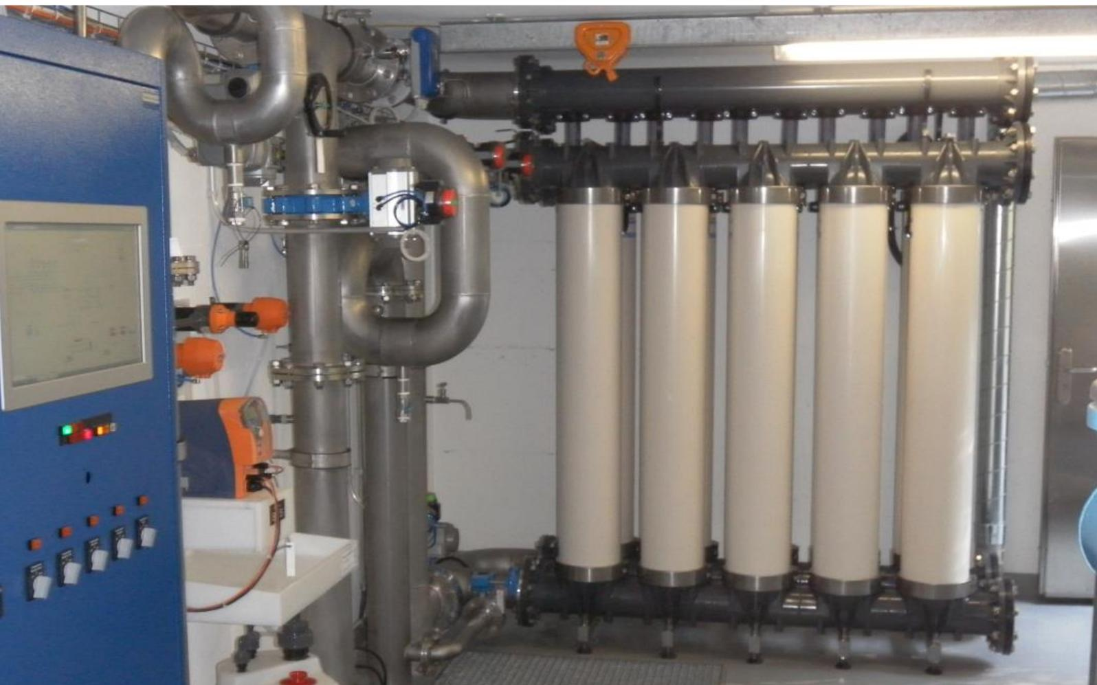
Der Neubau der Ultrafiltrationsanlage in einem bestehenden Gebäude erfolgte mit dem Ziel, eine effiziente und nachhaltige Trinkwasseraufbereitung sicherzustellen.
