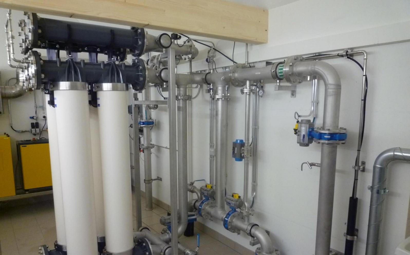
Der Neubau der Ultrafiltrationsanlage erfolgt als Ersatz für die bestehende Chlordioxidanlage, um eine chemikalienfreie, nachhaltige und zuverlässige Trinkwasseraufbereitung zu gewährleisten.
