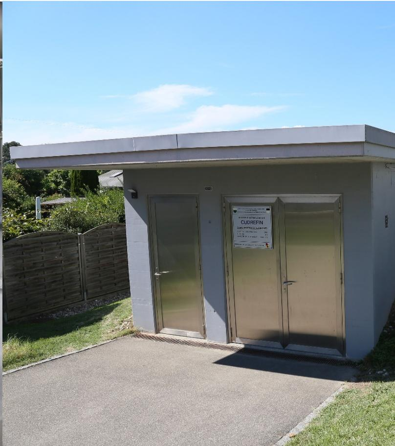
La nouvelle station d'eau potable de Cudrefin a été construite dans un bâtiment enterré. En 2013, elle remplace l'ancienne station de filtration de 1947 avec une capacité de 3'000 m<sup>3</sup>/j.
