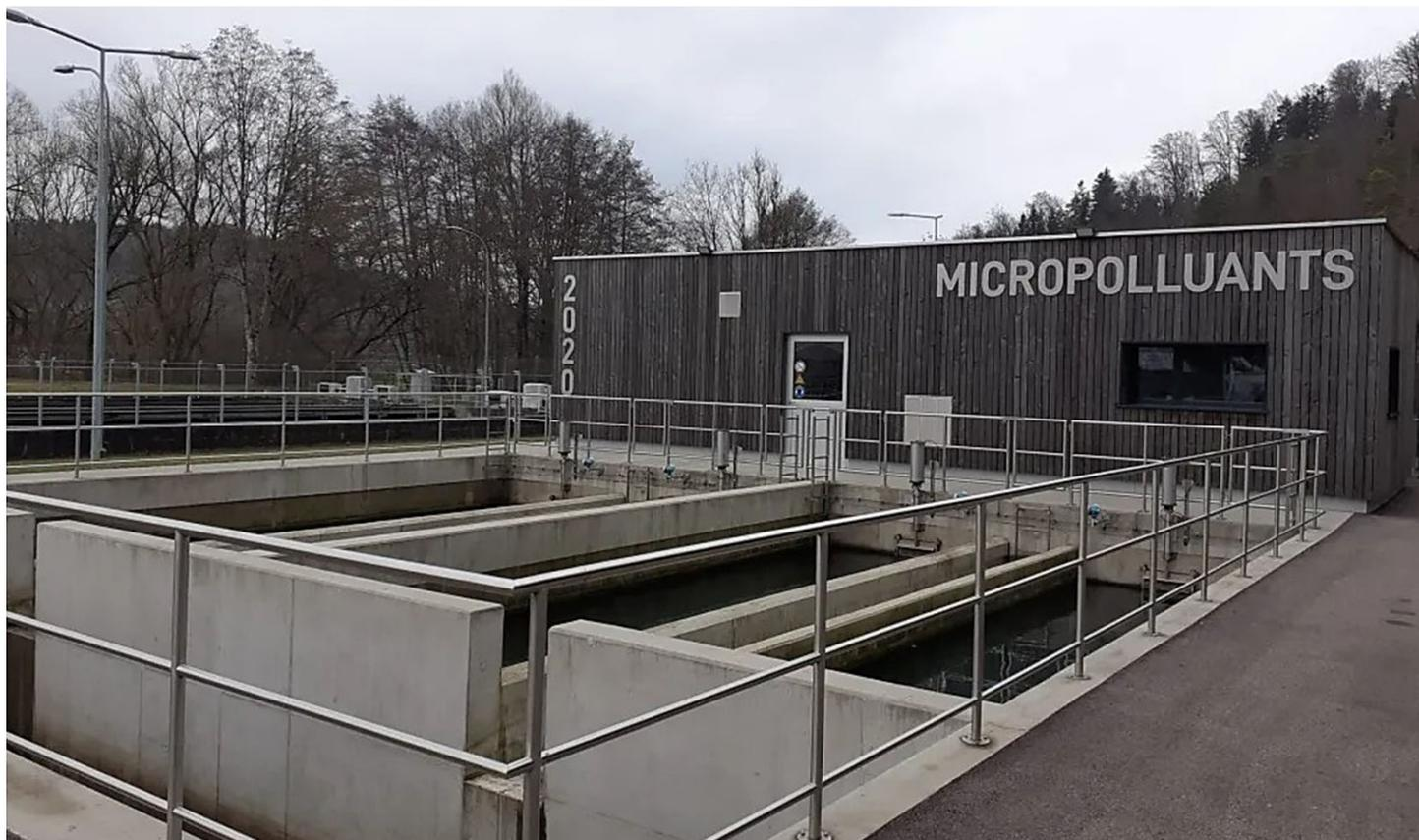
Suite à la modification de la loi sur la protection des eaux en Suisse, plusieurs stations d'épuration ont besoin d'une nouvelle étape de traitement pour abattre les substances traces organiques.
